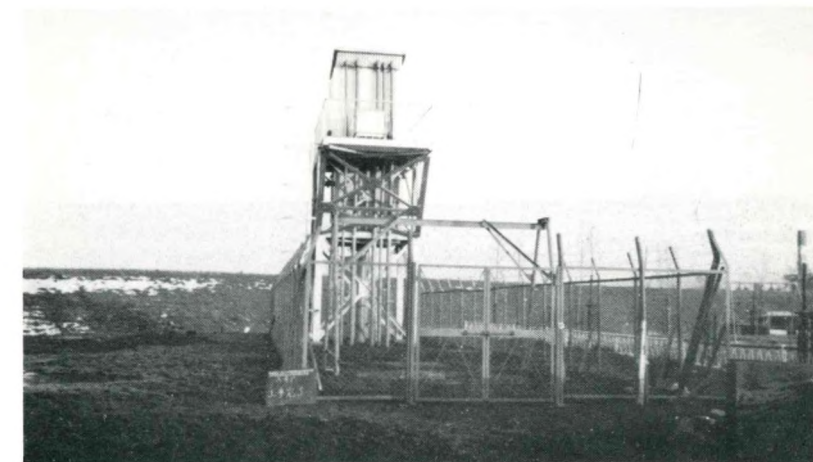
揚水曝気高架槽
