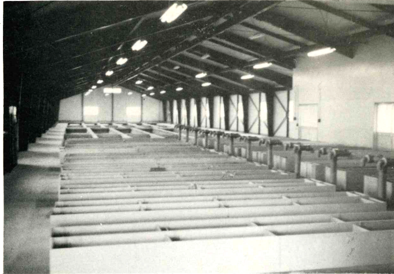
ふ化室、屋内稚魚池 (660㎡)
