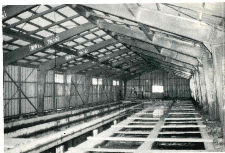
鉄骨造り波長尺鉄板ぶき 面積 560,45M 2
