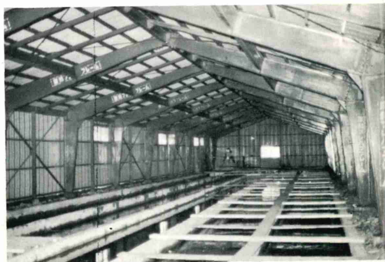
鉄骨造り波長尺鉄板ぶき 面積 560,45M 2
