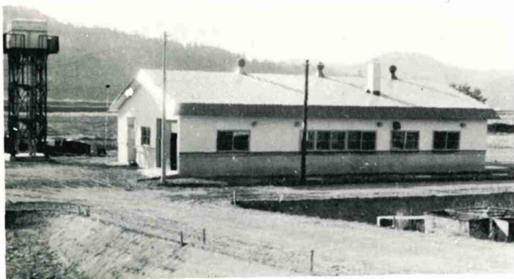
渚滑事業場 昭和46年10月竣工 総工事 19,322千円 建物面積 198M 2 木造モルタル長尺鉄板ぶき
