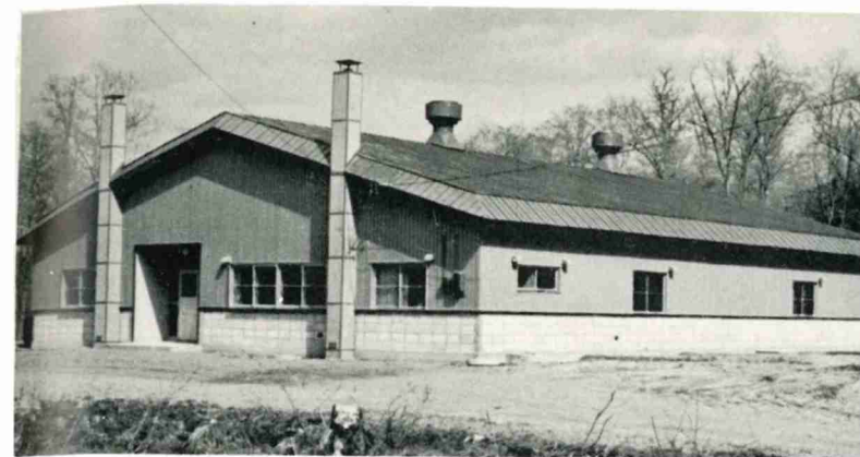
計根別事業場 昭和46年11月竣工 総工事費 16,648.6千円 建物面積 364M 2 鉄骨造長尺鉄板ぶき
