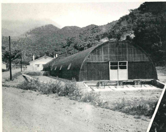
岩尾別事業場 上家 鋼管構造長尺カラー アーチ型鉄板ぶき 592m 2 工 費 530万円
