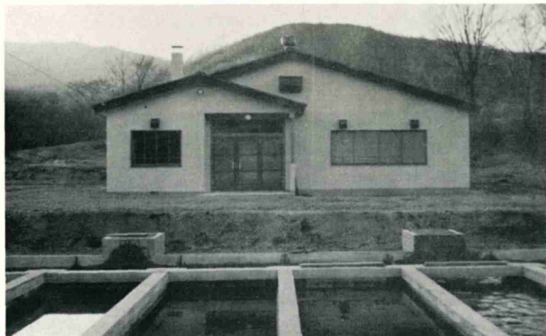
敷生事業場新設 昭和45年10月竣工 総工事費 1,478万円 敷地（借地） 8,449㎡
