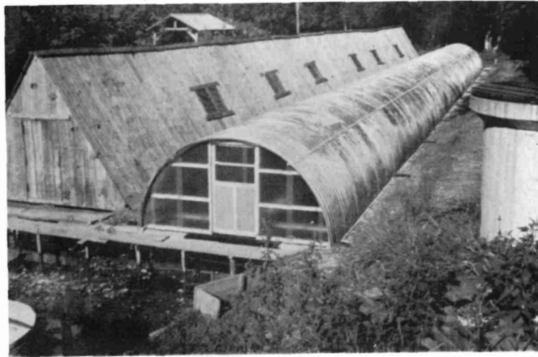
岩尾別事業場 上家 鋼管構造長尺カラー アーチ型鉄板ぶき 592m 2 工 費 530万円
