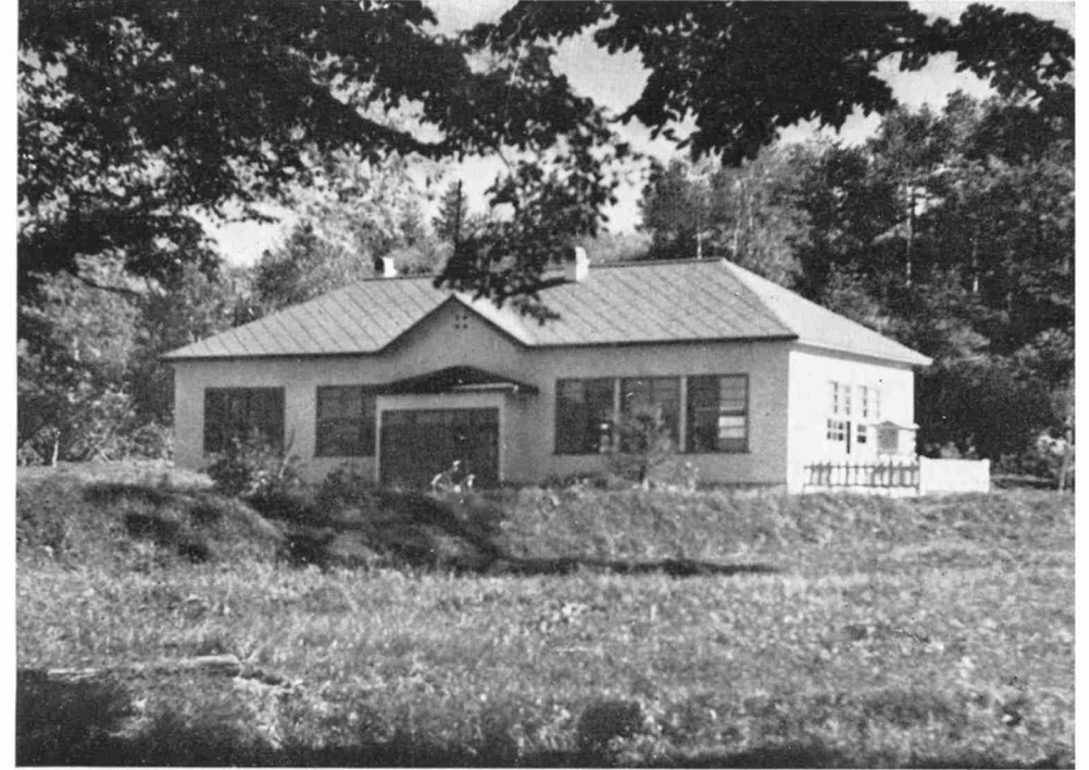
根室支場新庁舎
