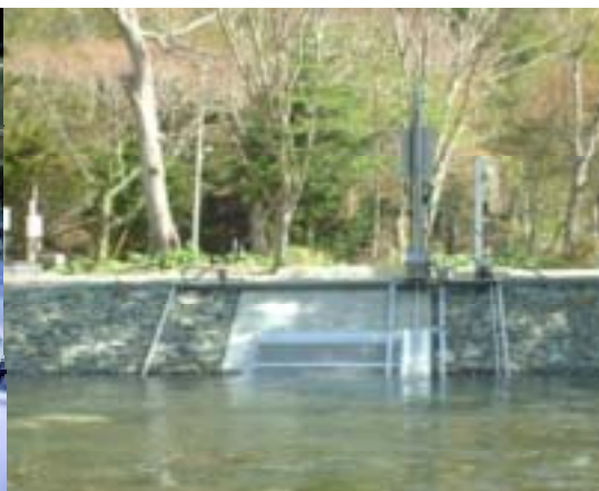
写真2 河川水取水設備。
