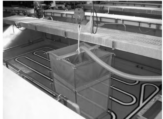
写真Ⅲ-7 排水用アンドン
