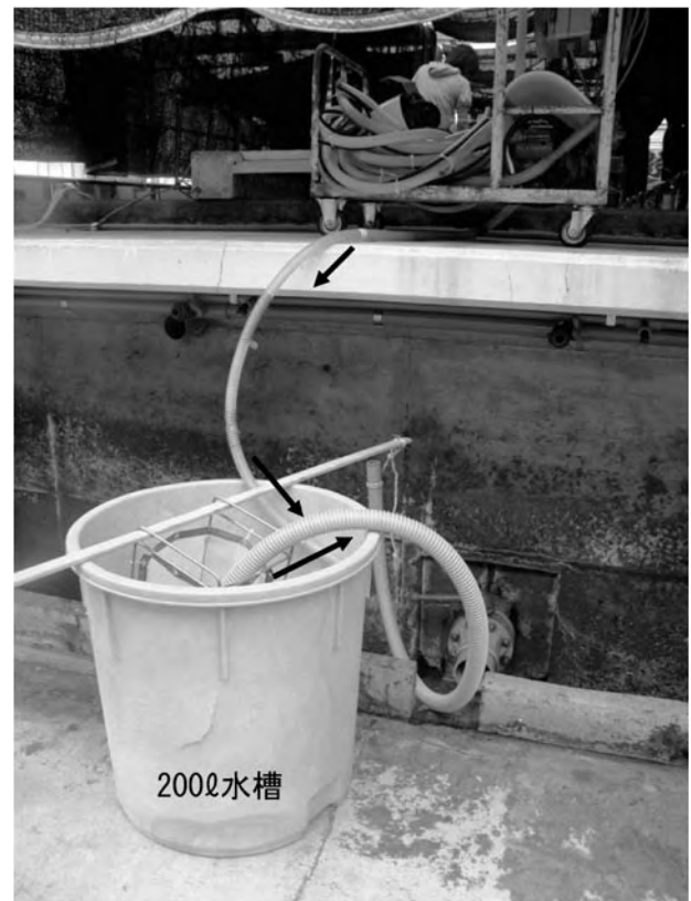
写真Ⅲ-9 底掃除の排水方法 矢印は排水の方向を示す
