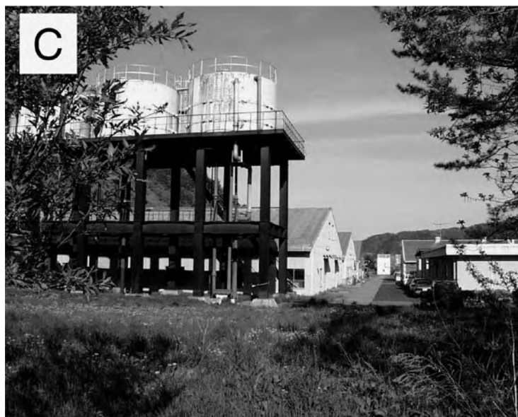
写真Ⅲ-8 センターの飼育用水のろ過装置 A：圧力ろ過装置，B：重力ろ過装置，C：高架型の貯水槽
