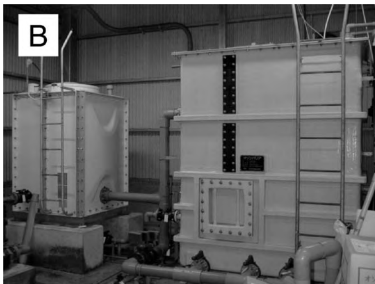
写真Ⅲ-9 飼育用水をオキシダントで殺菌処理するオゾンバリア A：オキシダント発生器を内蔵する制御盤 B：オキシダント反応・吸着槽（右）と処理水貯水槽（左）
