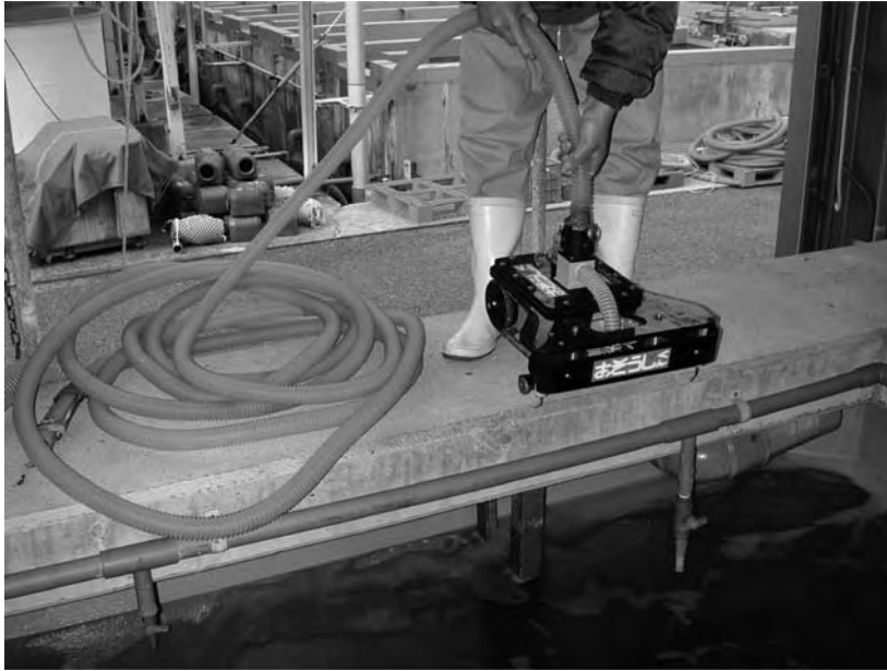
写真Ⅱ-2-15. 自動底掃除機の投入
