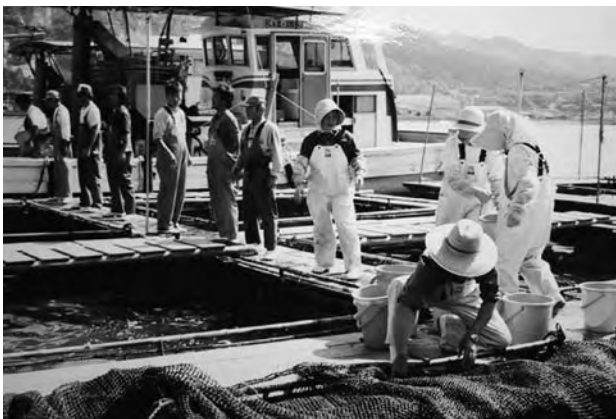
写真Ⅲ-2-4 海上小割生簀でのバケツリレーによる種苗の積み込み（屋島栽培センター）
