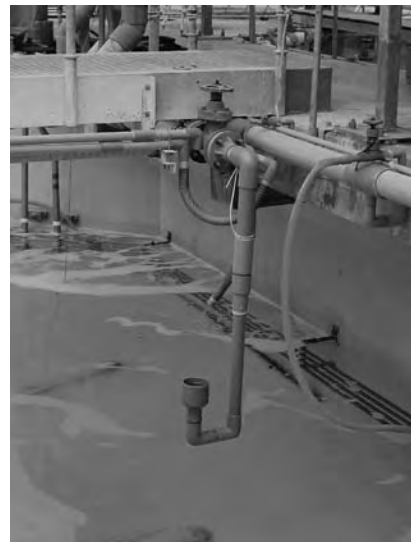
写真Ⅱ-2-5. 注水口を上に向けた注水方法（上浦栽培センター）
