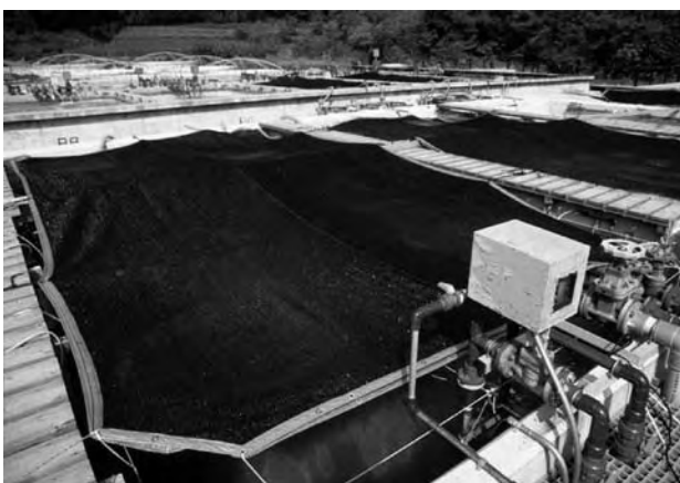
写真II-2-9. 水槽上面に設置した遮光幕 (五島栽培センター)
