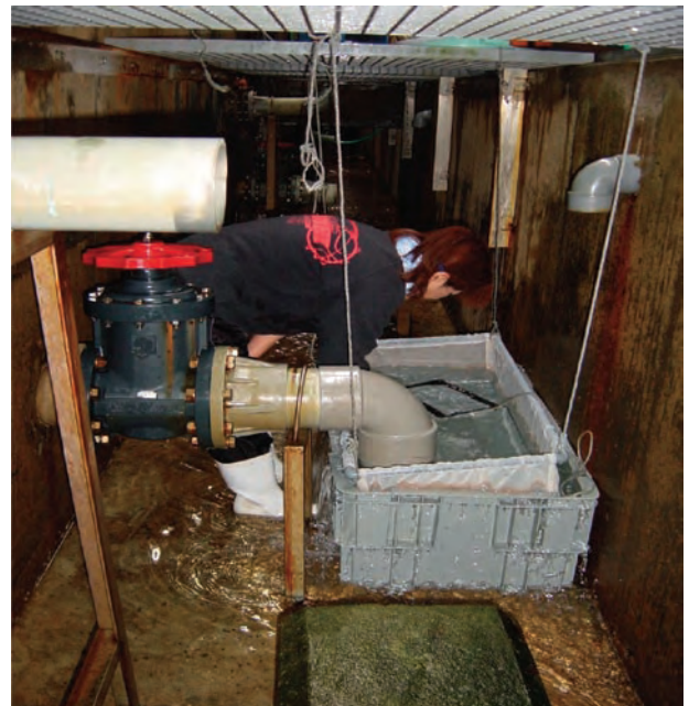
写真Ⅱ-5-3. 排水溝からの取り揚げ
