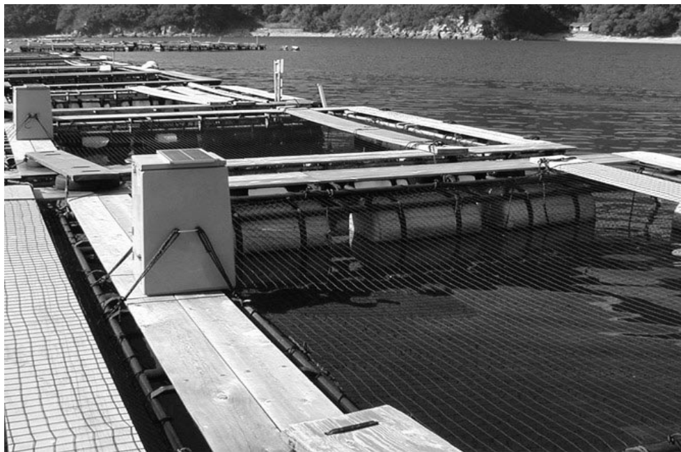
写真2-5. 海上小割に設置されたソーラー充電式の自動給餌器
