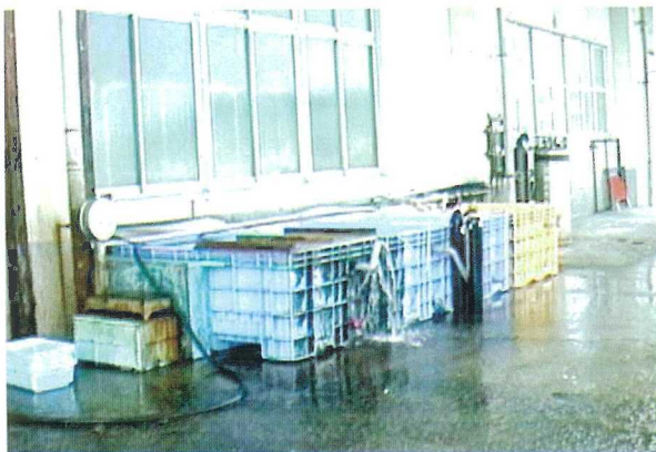
写真IV 1-3 荷捌き所の保管水槽
