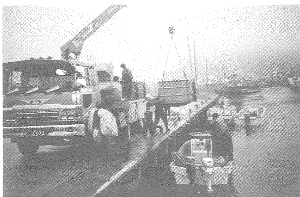
写真IX 3-4 沖出し：クレーンで輸送水槽を釣り上げて輸送船へ設置
