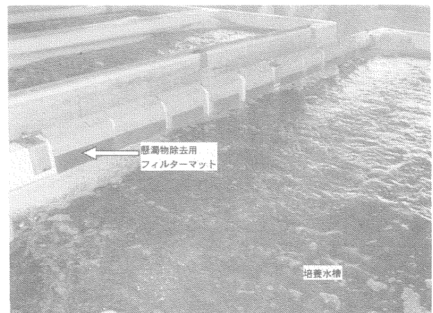
図Ⅱ 2-10 14m 3 水槽での懸濁物除去用フィルターマットの使用事例
