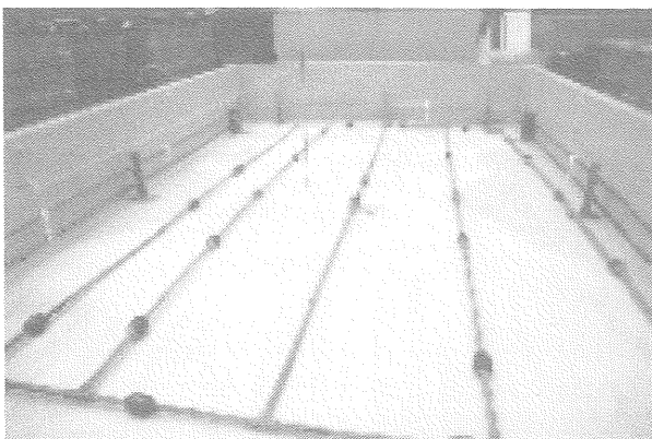
図Ⅱ 2-9 10m 3 コンクリート水槽の通気用空気配管
