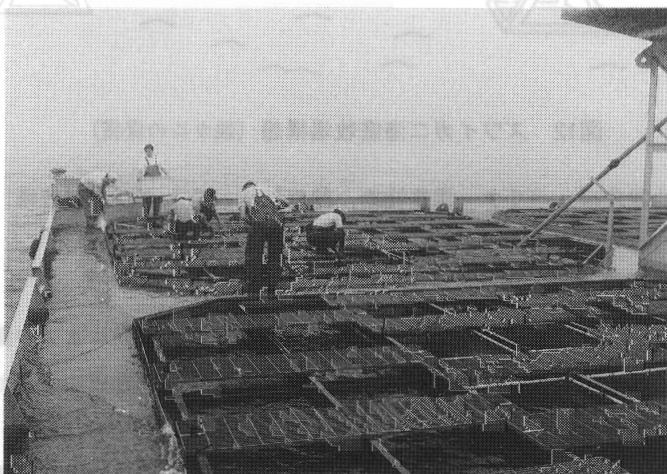
図11 潜降浮上型人工海底「マリンあや1号」, 浮上状態
