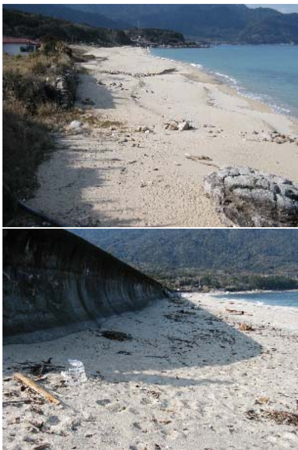
図9. (上) 屋久島永田地区、田舎浜の様子。所々に見られる段差は台風によりえぐられた跡 (下) 前浜に設置された防潮堤
