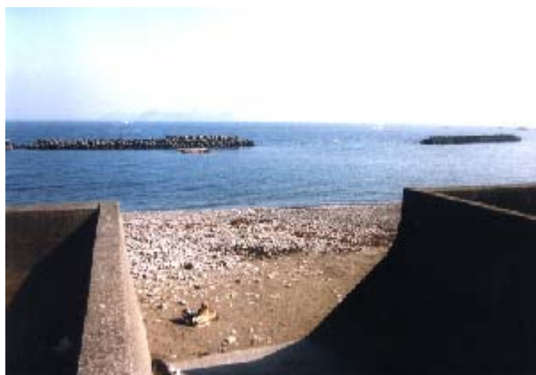
図6. 蒲生田海岸に設置された消波ブロック堤
