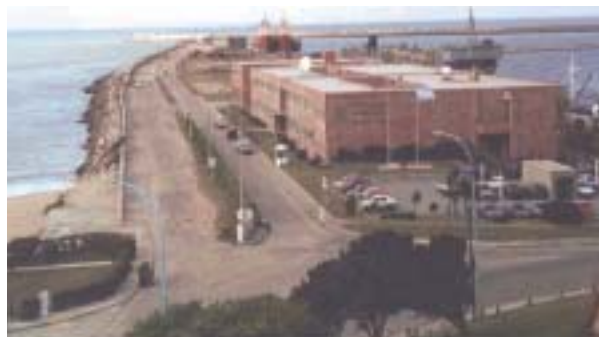
図1. 日本の無償資金協力で1993年に完成した国立水産調査開発研究所 (INIDEP)
