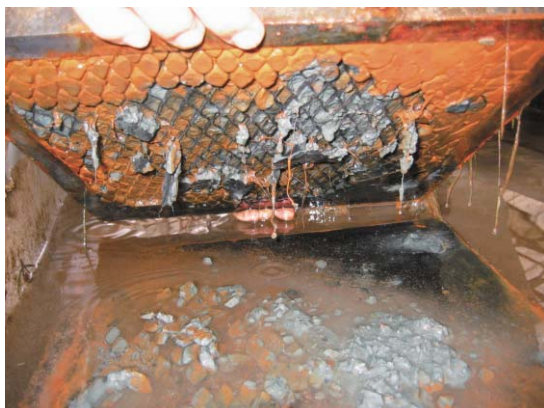
Photo. 10 岡山水産試験場屋内水槽日生底質セメント系2% (2003/5/15) 型枠底部よりヒゲ根露出
