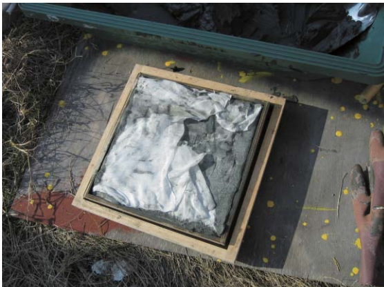
Photo. 5 脱型設置型木製小型型枠打設・成型
