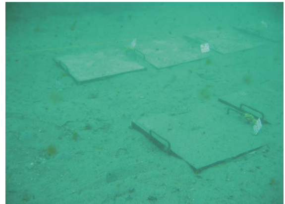
Photo. 3 一体設置型鋼製型枠固化体設置
