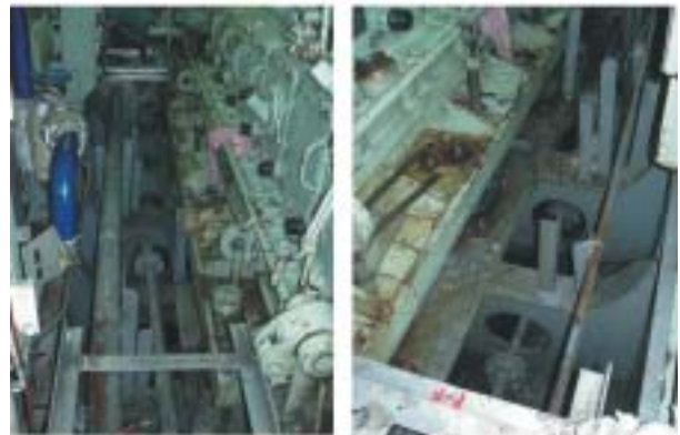
主機関防振ゴム交換工事
