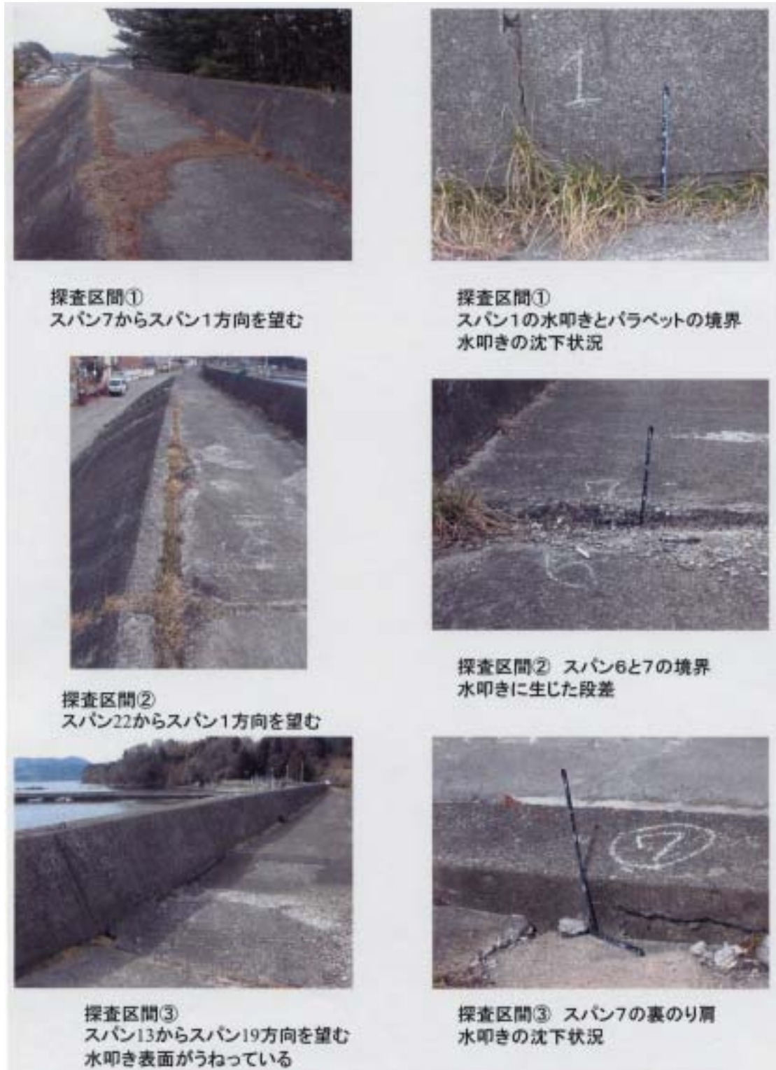
図5 探査区間の外観写真
