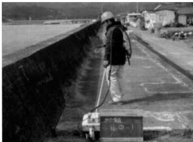
図8 探査状況写真
