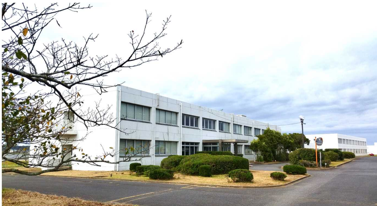
神栖庁舎 (研究本館（左手前）と研究管理棟（右奥）)
