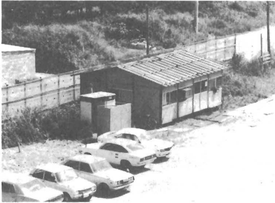
仮設のプレハブ事務室（昭和54年3～11月）
