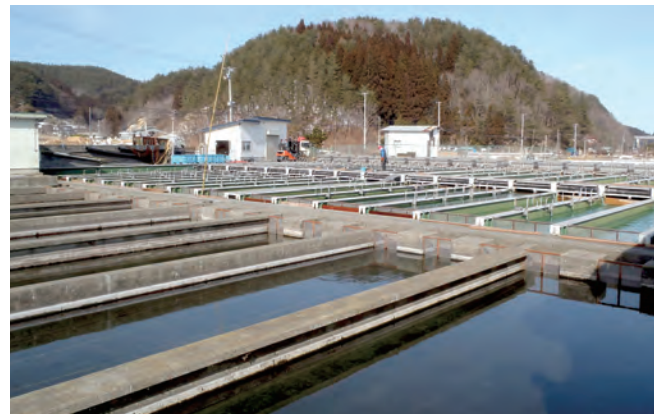
写真1 震災の翌春の織笠ふ化場。震災時は約1,770万尾のサケ稚魚を生産していた。津波の被害は免れたものの、飼育池と導水管の一部を破損。現在は完全復旧し、さらに山田湾の拠点として集約施設の新設整備が進められている。
