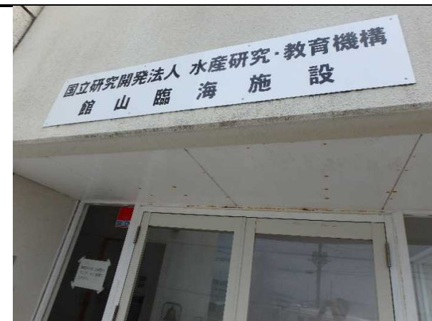
③北側入口庁名板付近（庁名板は塗装除外）
