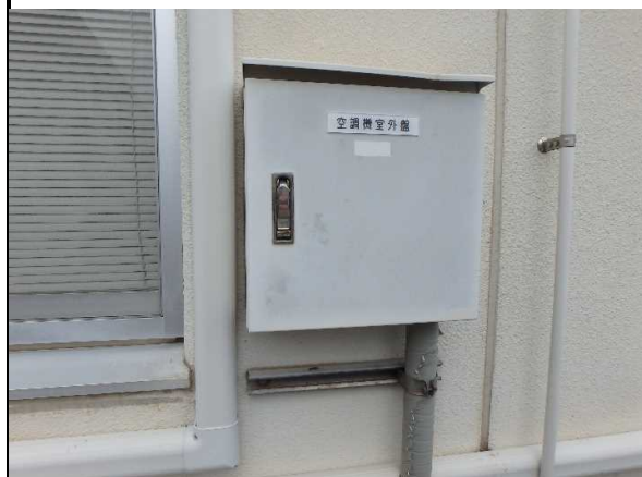
④西側空調機室外板付近
