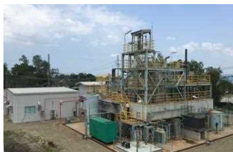
セルロースエタノール化設備
