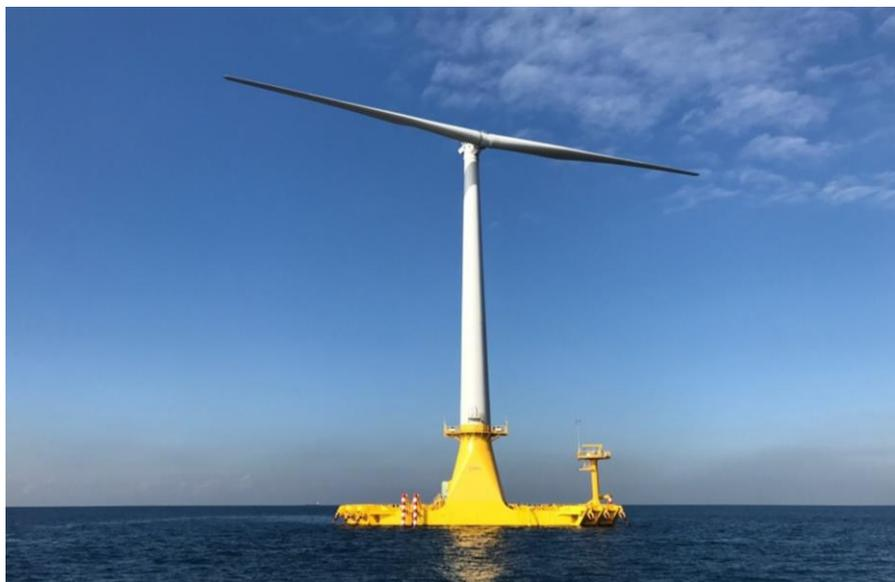
バージ型浮体式洋上風力発電システム実証機「ひびき」
