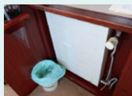
船内にパネルヒーター設置。北国仕様の船です。
