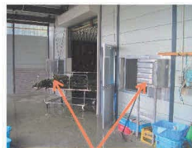
排気ファンの新設
